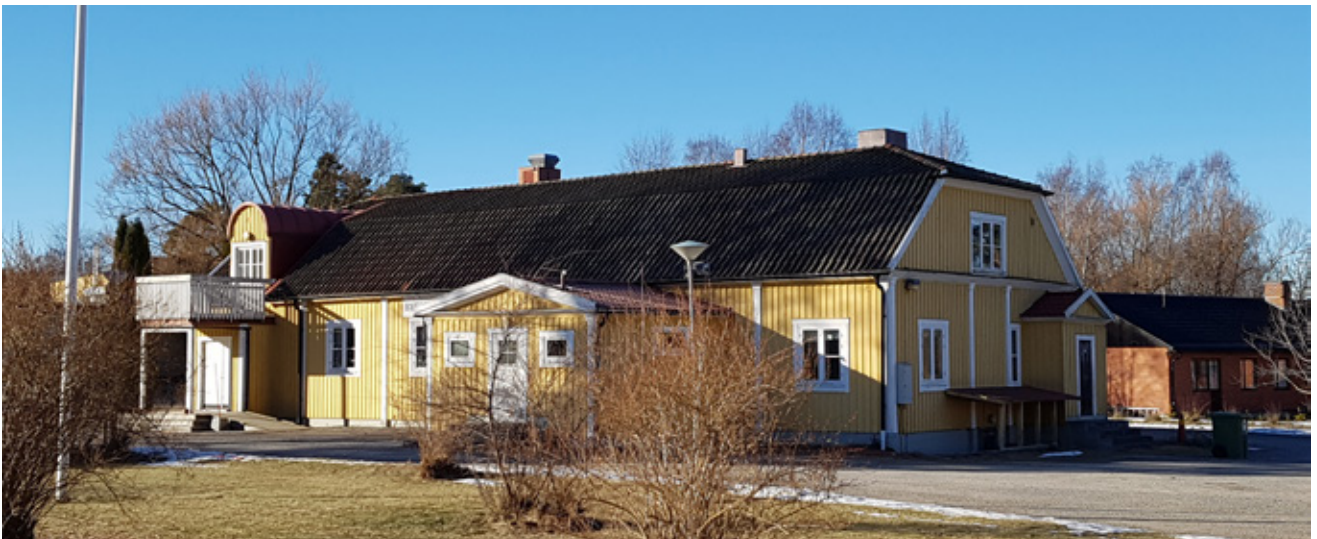
Västerhaninge bygdegård uppfördes av Bondeförbundets lokalavdelning år 1929 längs med gamla landsvägen, ca 250 meter om kyrkan. Byggande är utpekad och beskrivs närmare i kulturmiljöinventeringen - Västerhaninge. Foto Tobias Mårud
