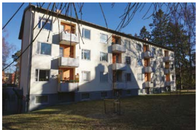
En av byggnaderna från den första etappen. Foto: Tobias Mårud
