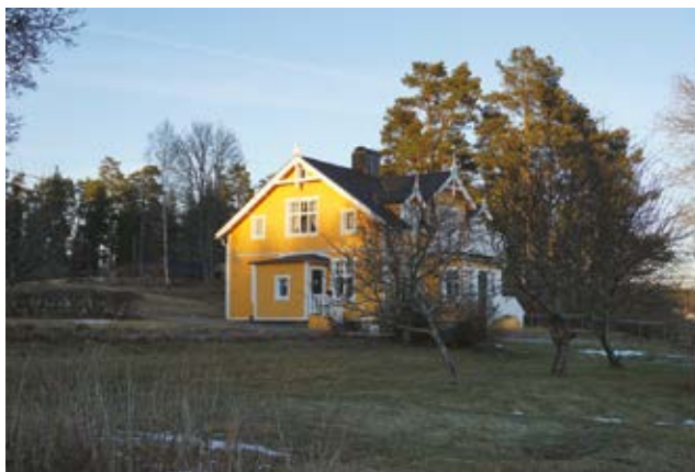
Manbyggnaden på Skarplöt. Foto: Tobias Mårud.
