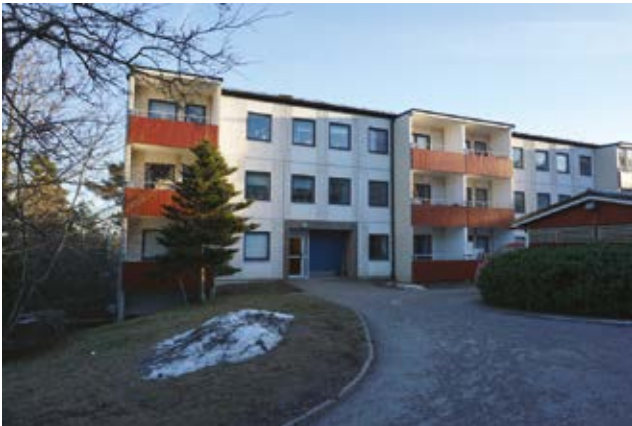
Entrésidorna är försedda med utanpåliggande, inbyggda balkonger. Foto: Tobias Mårud.
