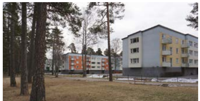
Den tredje etappens byggnader är en tillbakagång till parallellt ställda lameller. Kontakten med skogen och naturen är fortfarande påtaglig. Foto: Tobias Mårud
