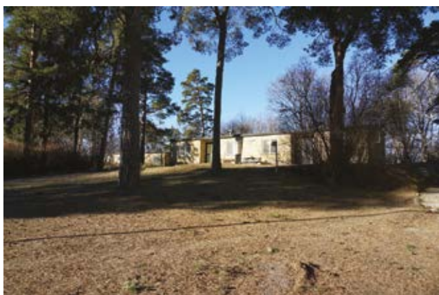
Elevhemmen är omsorgsfullt placerade i bevarad terräng. Foto: Tobias Mårud.
