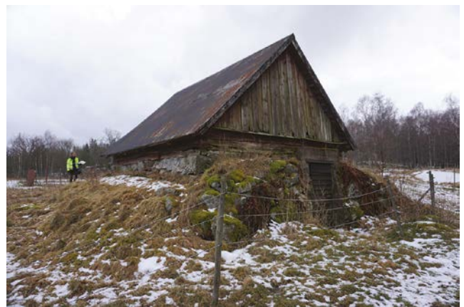
Källarbod på Välsta 2:16. Foto: Tobias Mårud.
