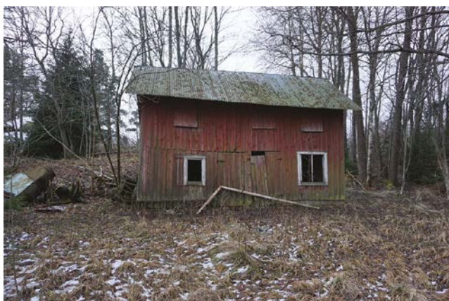
Tvättstuga med tork på övervåningen (Tungelsta 2:10). Foto: Tobias Mårud
