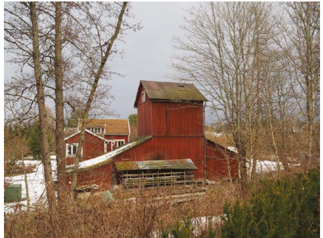
Vattentornet som försåg växthuset med vatten, Ålsta 1:22. Foto taget från kyrkogården i väster. Foto: Karin Myhrberg
