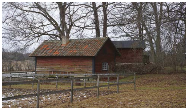
Tvättstuga och drängstuga på Välsta 4:3 och 4:4. Foto: Tobias Mårud
