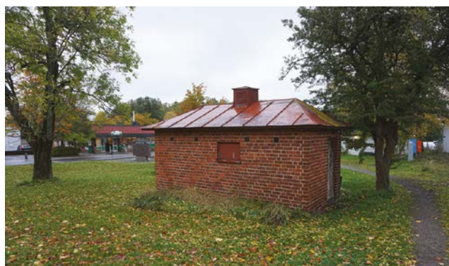
Transformatorbyggnad. Foto: Tobias Mårud
