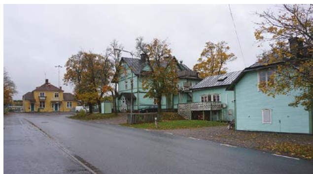
Vy mot stationen från Södertäljevägen. Mitt i bild syns den f.d. affären, Ålstalund (Ålsta 8:1), som är kraftigt ombyggt. Foto: Tobias Mårud
